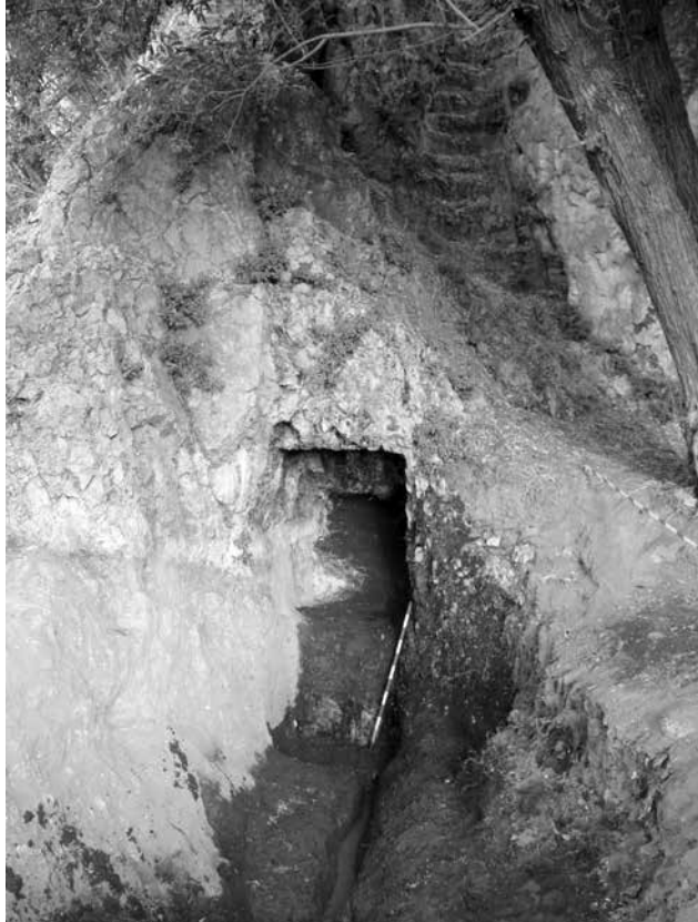
Fig. 4: Çeşme akarının yer aldığı niş, havuz ve kanal
